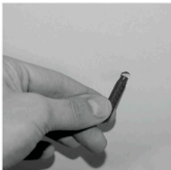
Просверлить отверстия на потолке и установить дюбели
